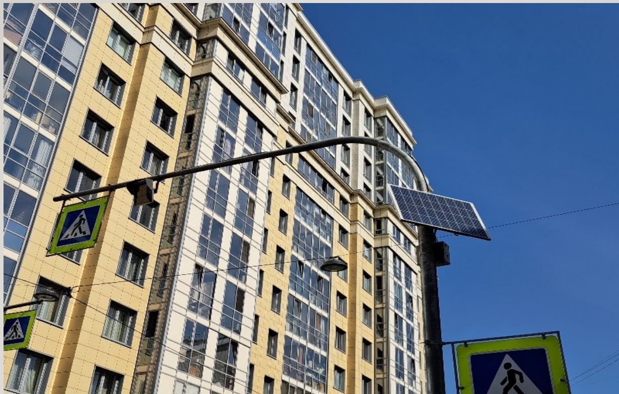
Солнечная панель для питания предупредительного сигнала над пешеходным переходом, ул. Киевская
